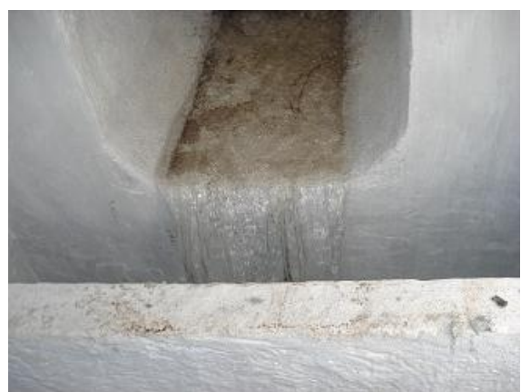
Ingreso al desarenador de pantalla
