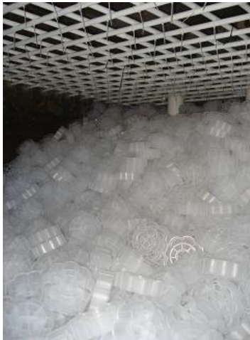
Detalle malla retenedora
