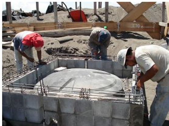
Muro superficial en block.
