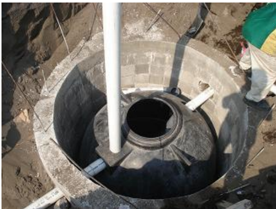
Muro perimetral en block
