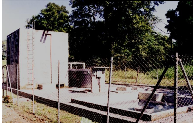
Tanque de bombeo e igualación rejilla de sólidos y desarenador
