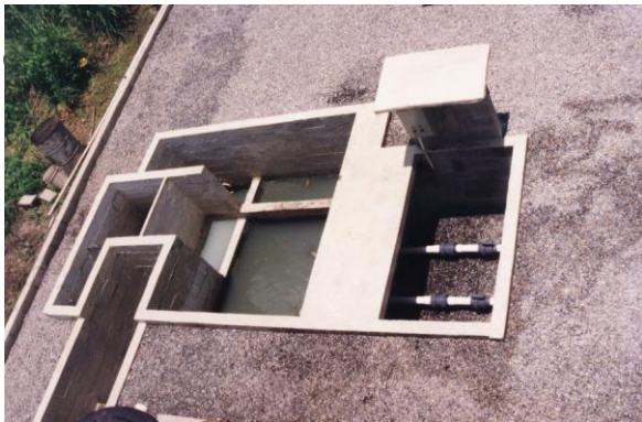
Tanque de bombeo e igualación rejilla de sólidos y desarenador
