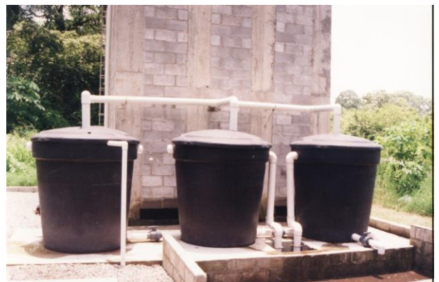
Digestores lodos y patio secado
