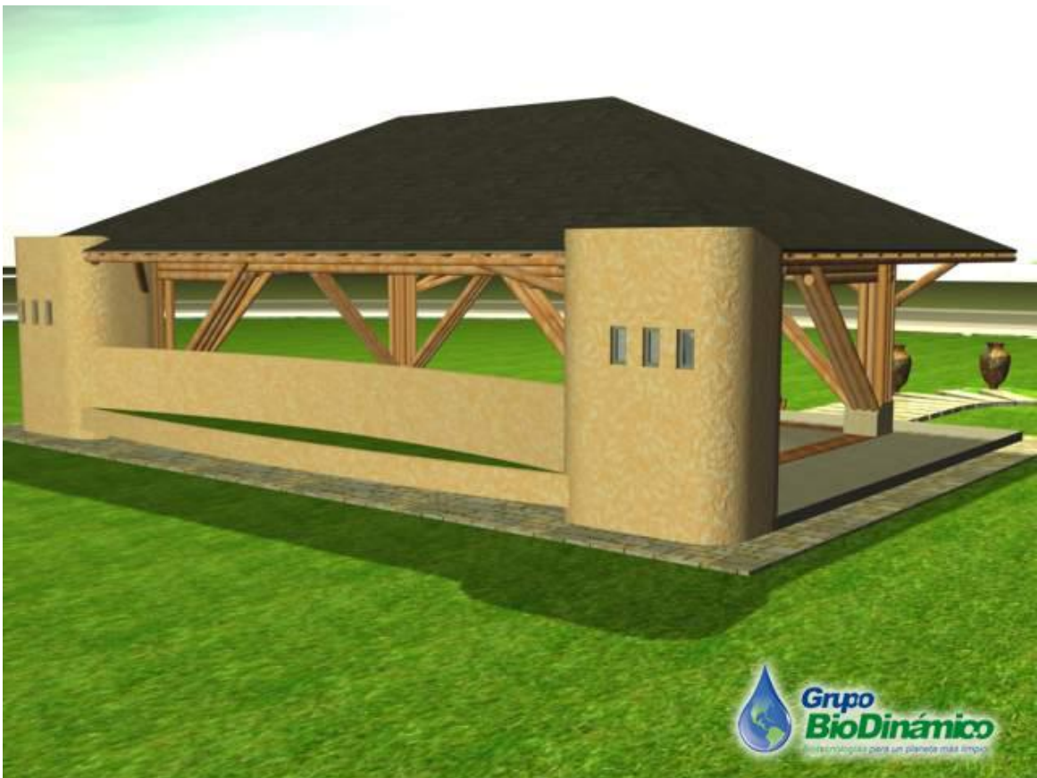
Vista aérea de cubierta con estructura en Guadua
